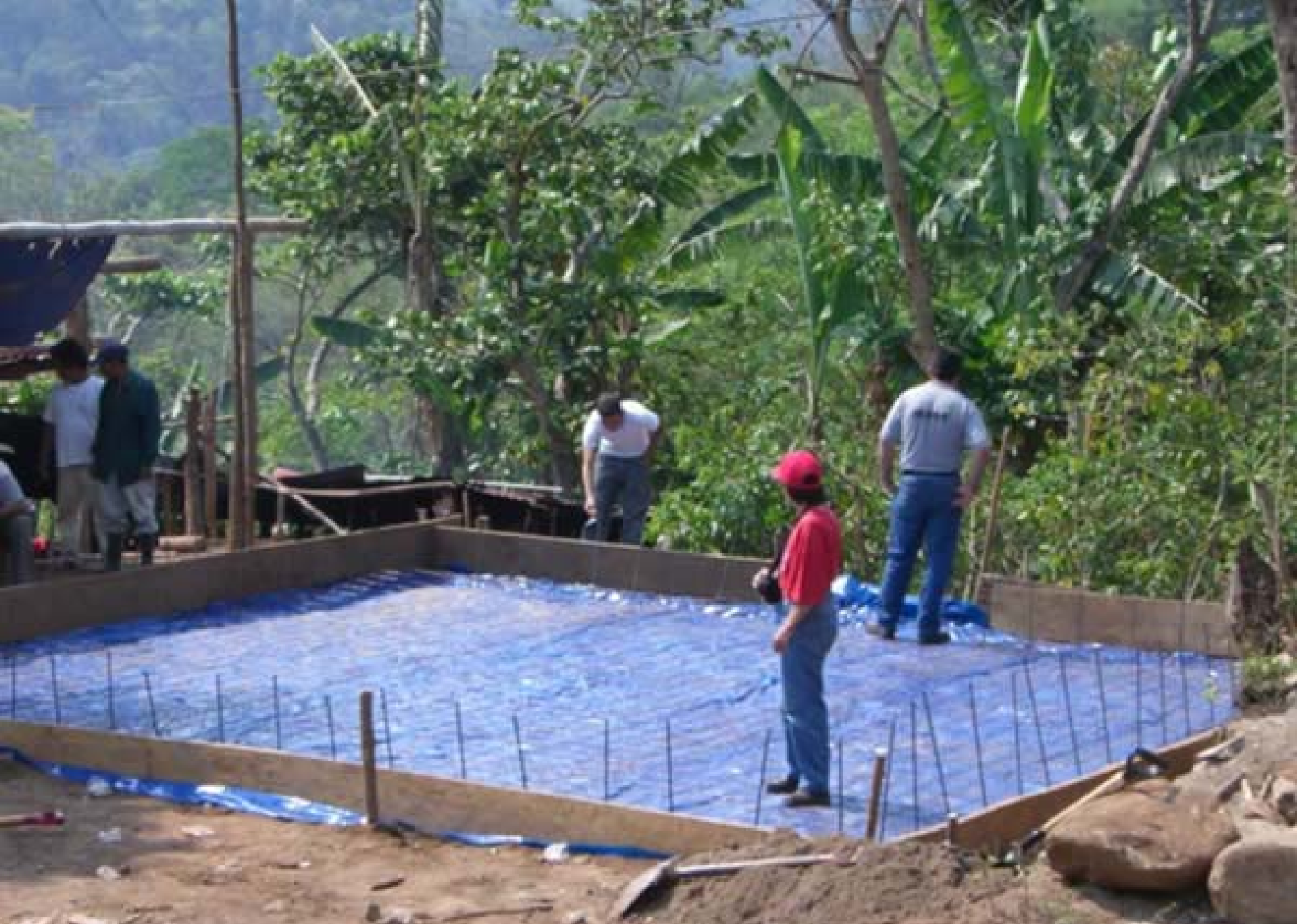
DIA 1: ARMADO Y COLOCACIÓN DE FRONTERAS
