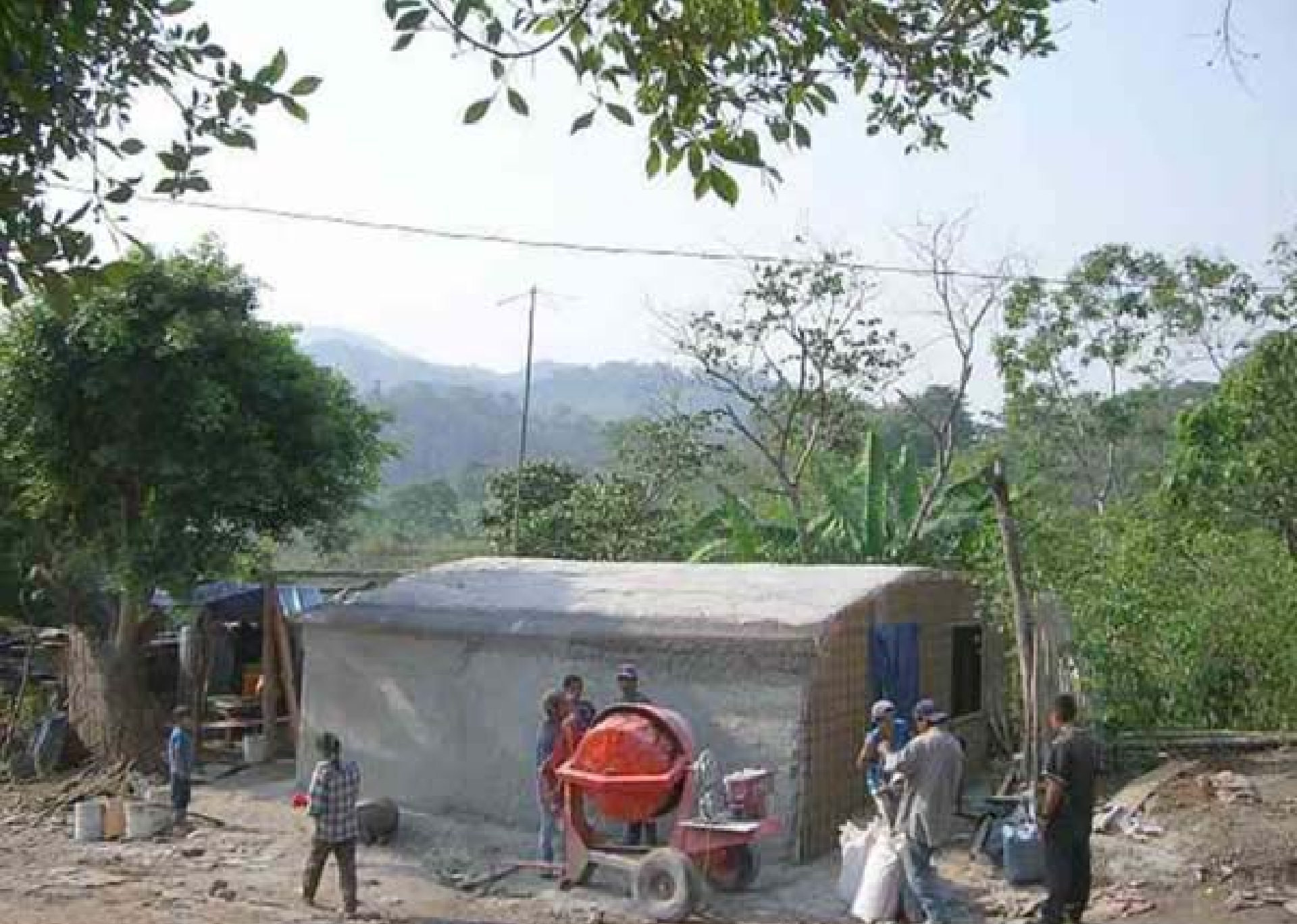
DIA 4: INSTALACION DE VENTANAS Y PUERTAS
