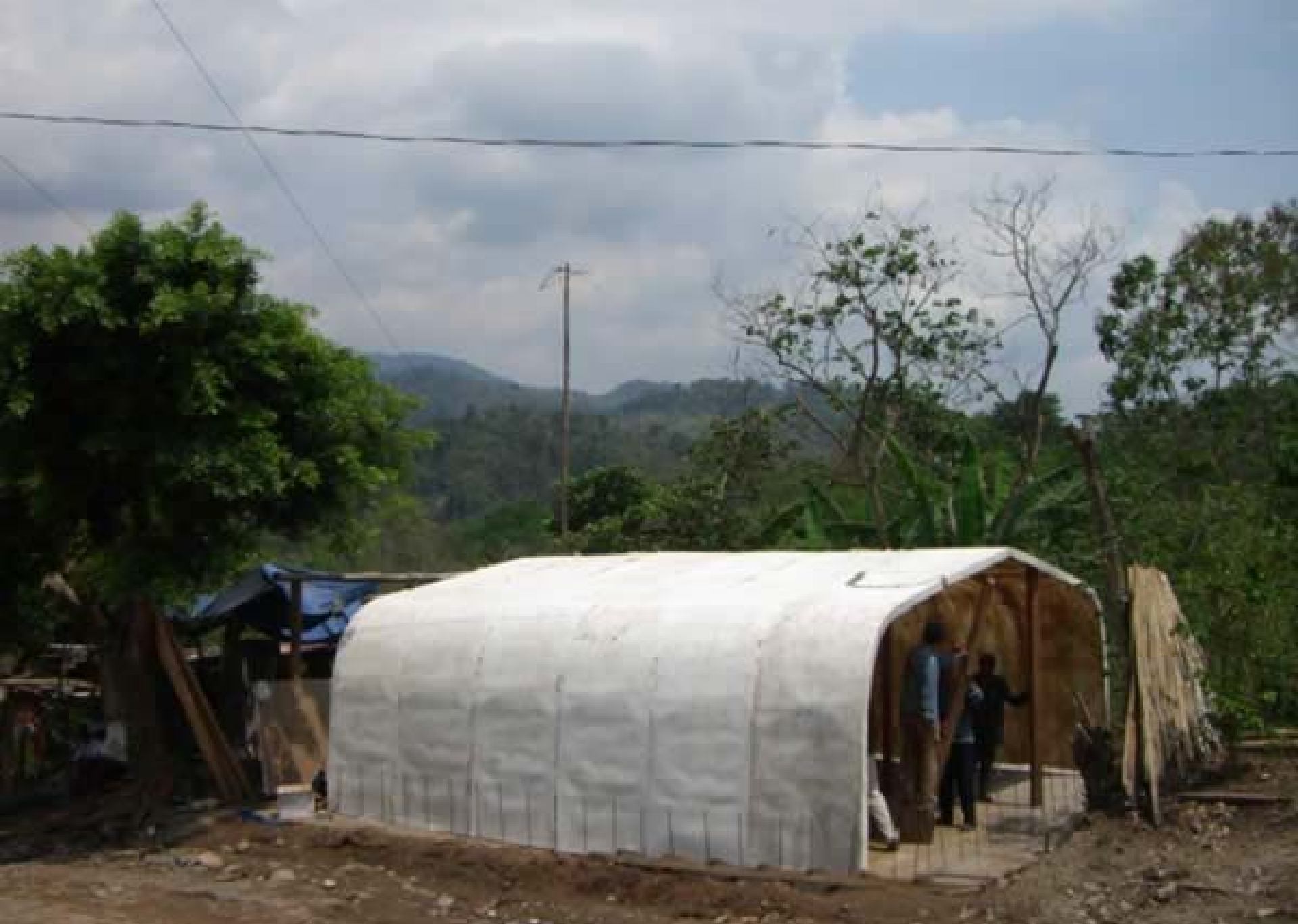
DIA 3: ARMADO DE CIMBRA
