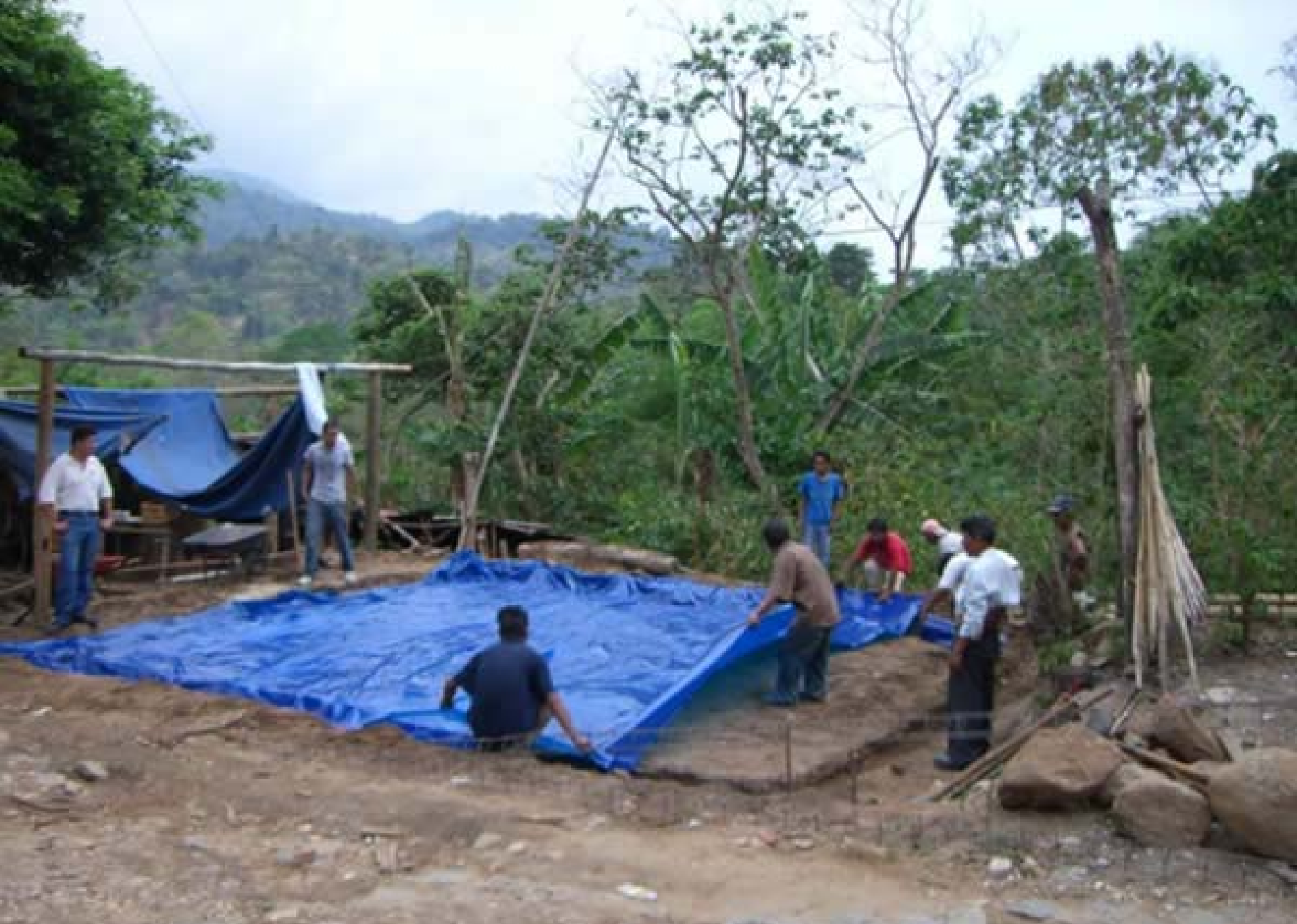
DIA 1: AISLAMIENTO DE LA BASE
