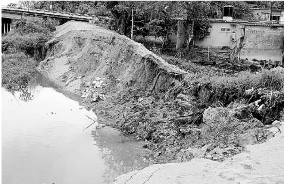
El bordo de tierra en la colonia Asunción Castellano fue severamente debilitado por las lluvias.
